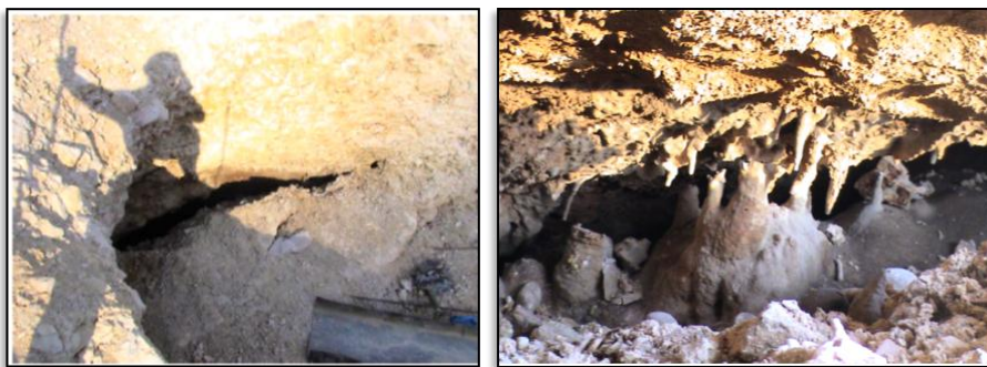
شکل ۸- حفره کارستی مشاهده شده در تکیه‌گاه راست سد. در تصویر زیرین استالاگتیت و استالاگمیت‌های نهشته شده در سقف و کف حفره نشان داده شده است (دید به سمت شمال شرق)
